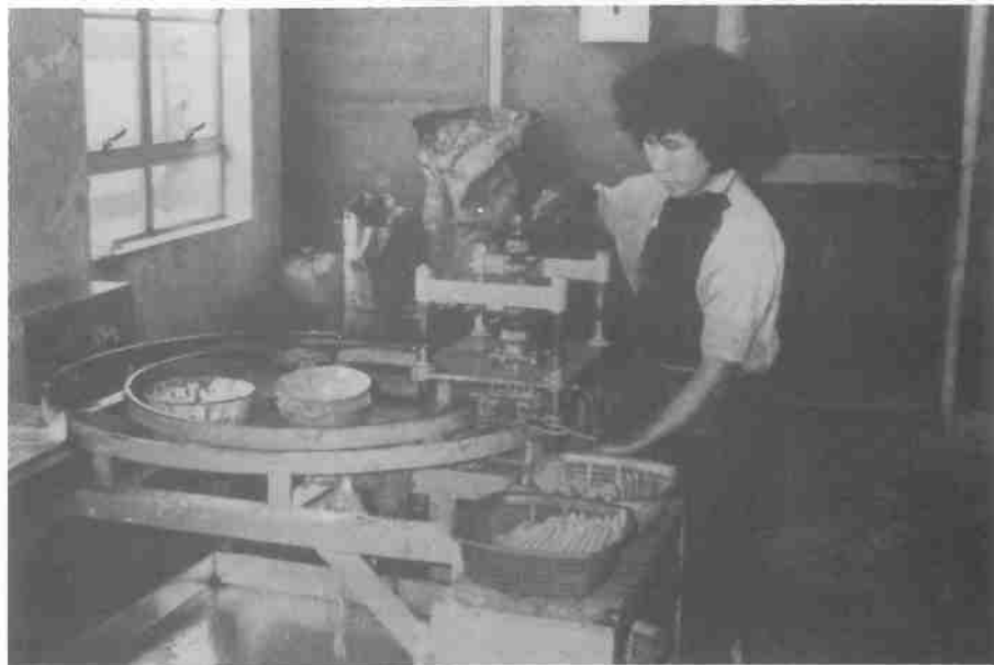
Fig. 15 - Máquina de fazer giz especialmente projetada para operadores cegos, que incorpora um prato giratório com dispositivos de paradas e de pressão para extração. (Foto: cortesia de Hong Kong Society for the Blind)
