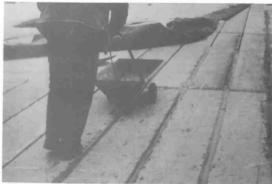
Fig. 40 - Método novo de despejar concreto, que inclui carrinho de mão e pá de pedreiro. (Foto: cortesia do Arbetsmedicininska Institutet, Estocolmo, Suécia)
