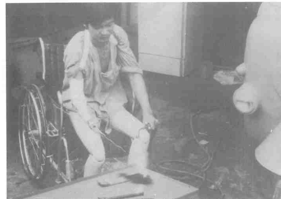
Fig. 34 - Dispositivo ortético especialmente projetado para um soldador com o braço direito amputado, capacitando-o a segurar a castina com seu braço direito artificial, enquanto opera um aparelho de soldar com a mão esquerda. (Coleção de Fotos da OIT, Genebra, Suíça)
