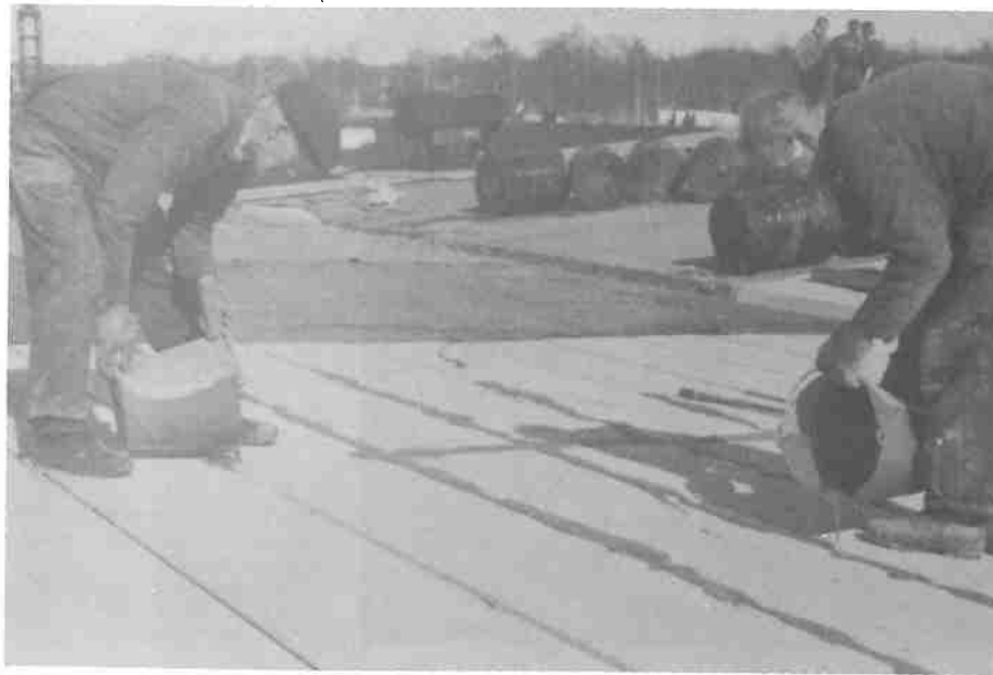
Fig. 39 - Método convencional de despejar concreto entre unidades de concreto pré-moldado. (Foto: cortesia da Arbetsmedicininska Institutet, Estocolmo, Suécia).
