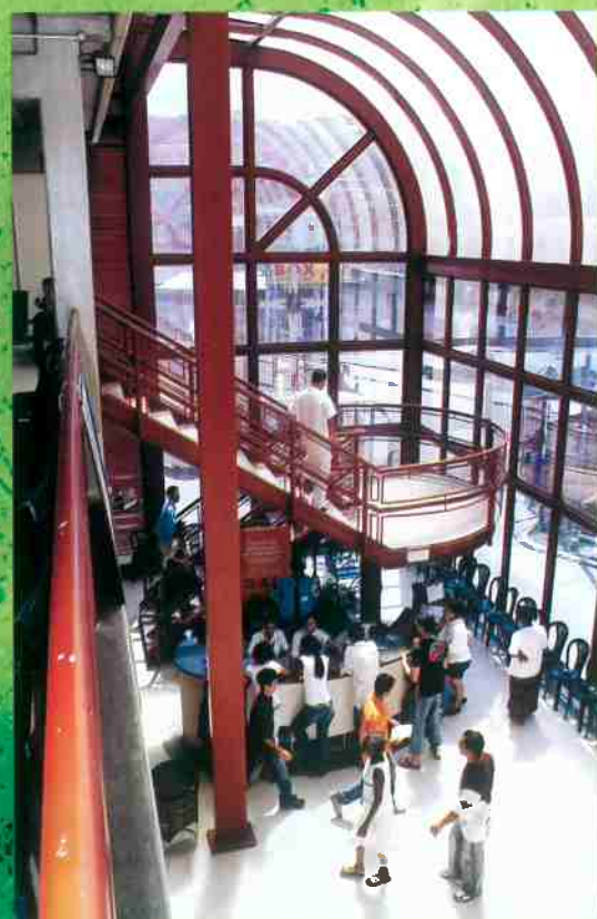
Prédio do CIC em Francisco Morato
