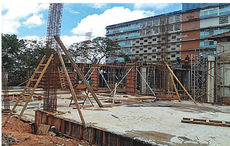
Memorial da Anistia em construção, 2014.
