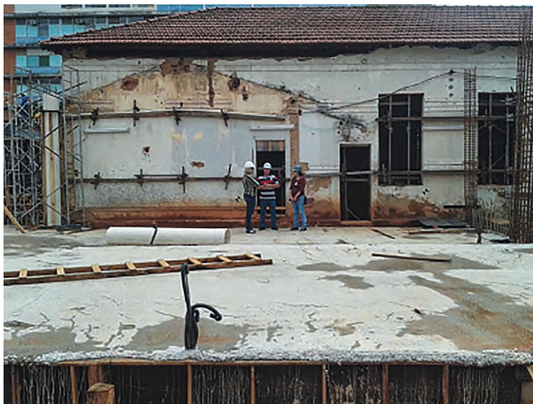
Memorial da Anistia em construção, 2014.
