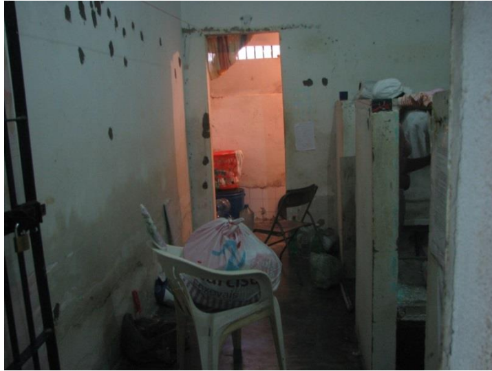
FIGURA 03: CELA EM REFORMA
