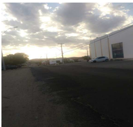
Figura 04: Rodovia Rn 288 Perímetro Urbano de Caicó/RN
