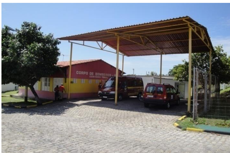
Foto 5: Estrutura do Quartel da 3ª Seção. Fonte: primária, julho, 2013.
