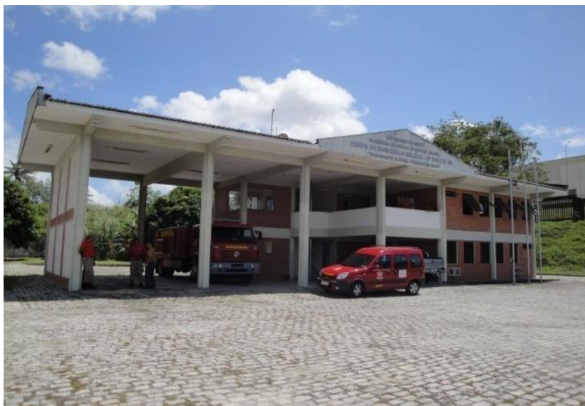
Foto 3: Estrutura do Quartel da 2ª Seção. Fonte: primária, julho, 2013.
