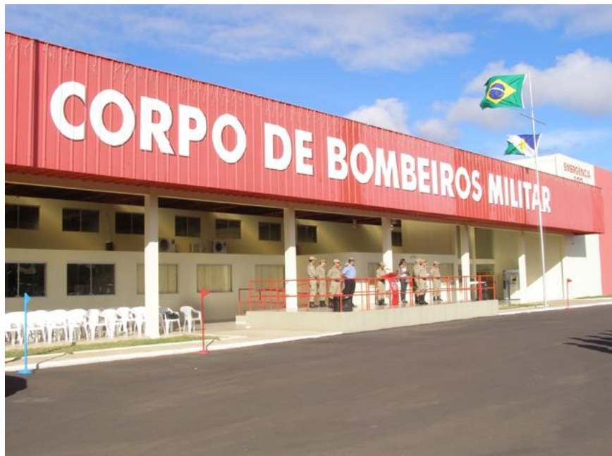
Figura 4 – Fachada frontal do Quartel do Comando Geral do CBMRR
